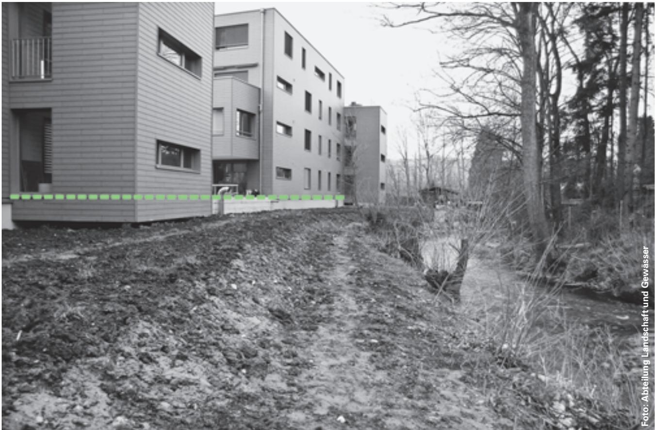
*Beispiel für Objektschutz an einem Neubau: Erhöhte Fensteröffnungen und Abluftrohre sowie eine Schutzmauer für den Innenhof machen dieses Gebäude bis zur grün gestrichelten Linie sicher vor Hochwassern.*
