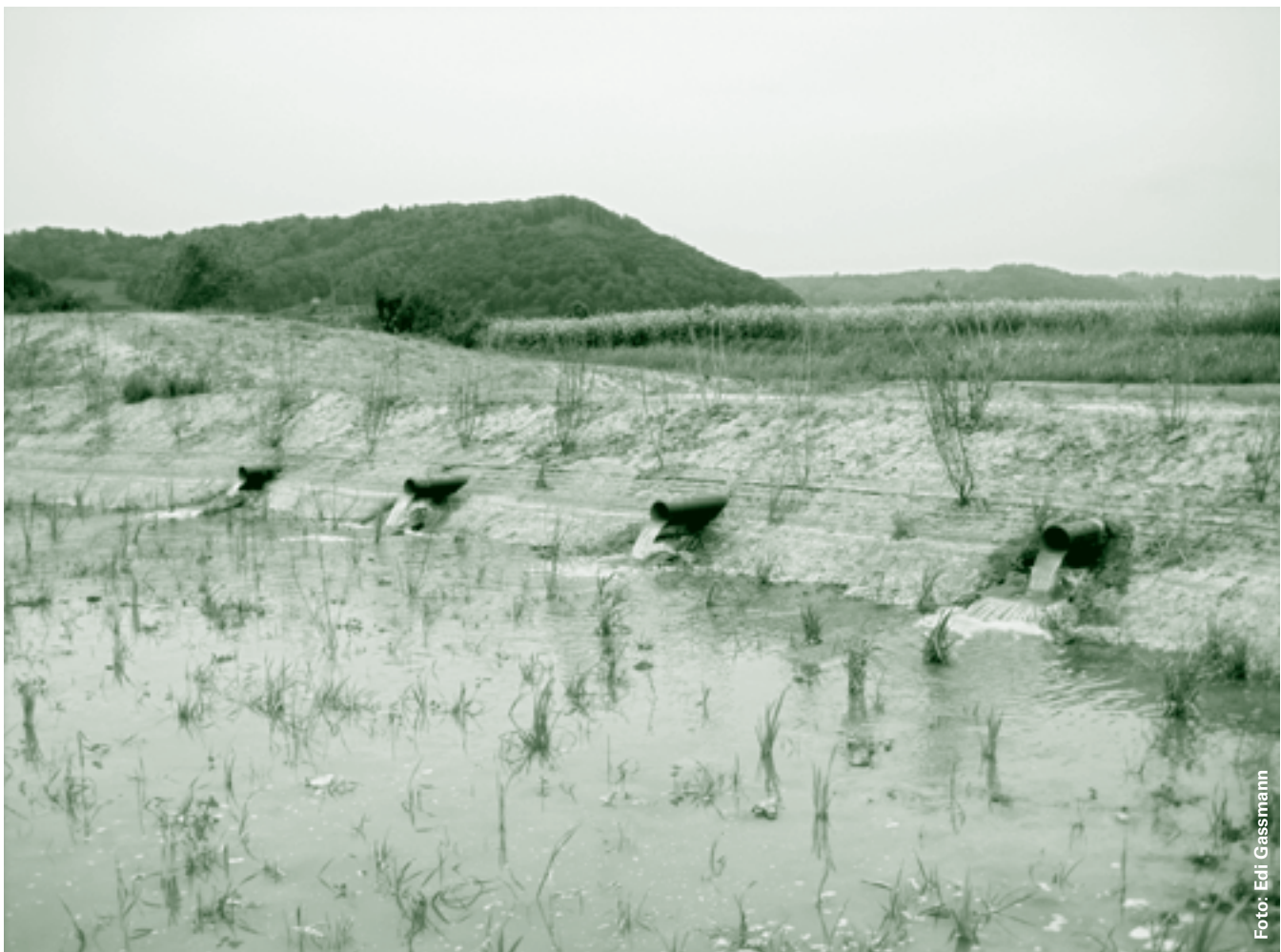
Einleitung des Wassers aus der Vormulde in das bewachsene Versickerungsbecken
