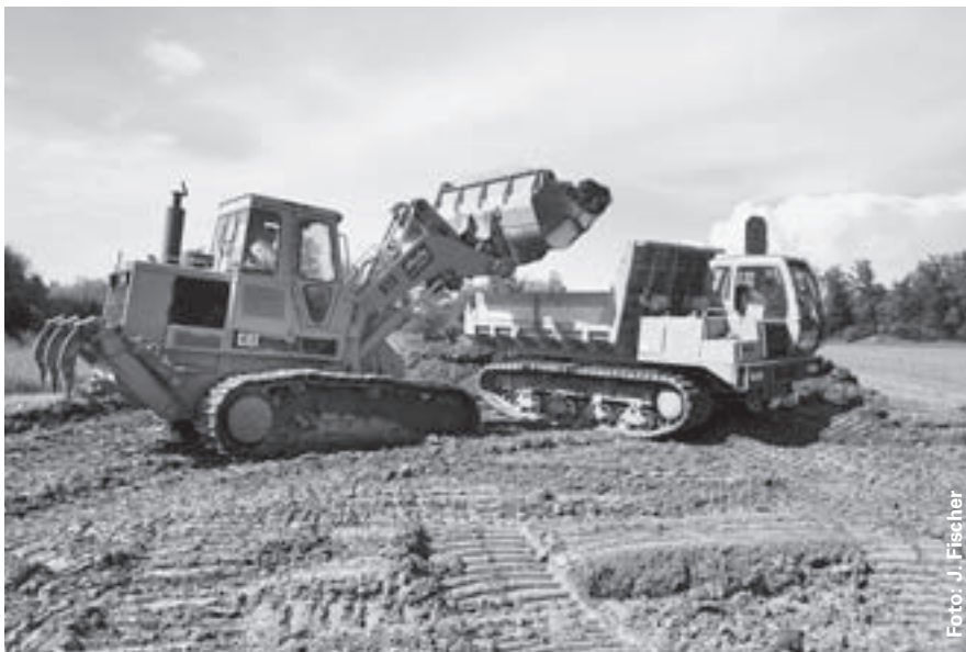
Die Umgestaltung in der Studweid Rottenschwil erfolgte mit Raupenfahrzeugen, um den Bodendruck möglichst gering zu halten.
