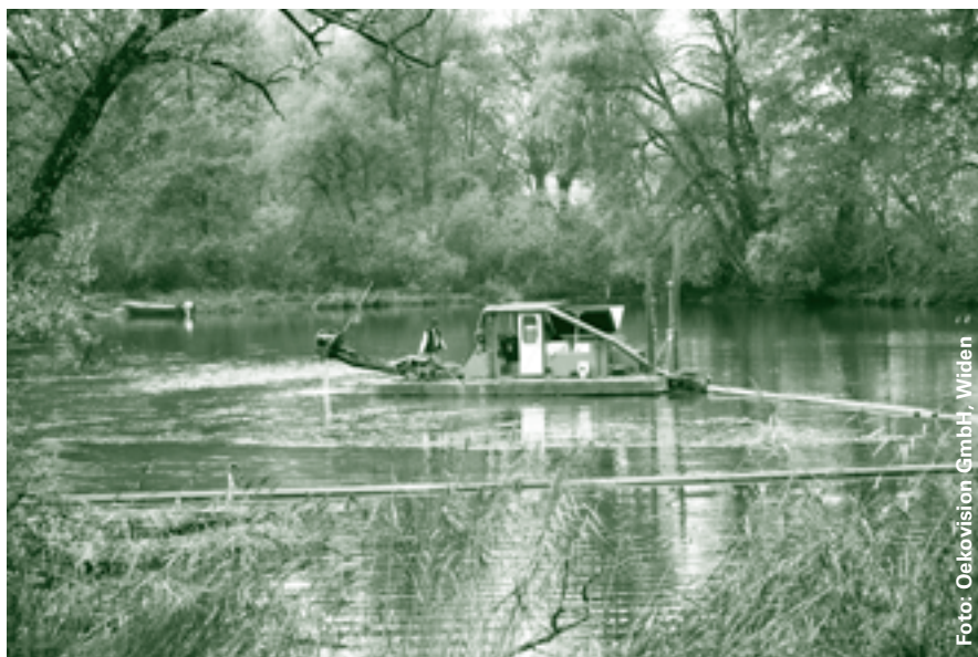
Der schwimmende Saugbagger fräst Pflanzenteile ab und pumpt sie zusammen mit dem Schlamm durch ein langes Rohr in ein Spülbecken.
