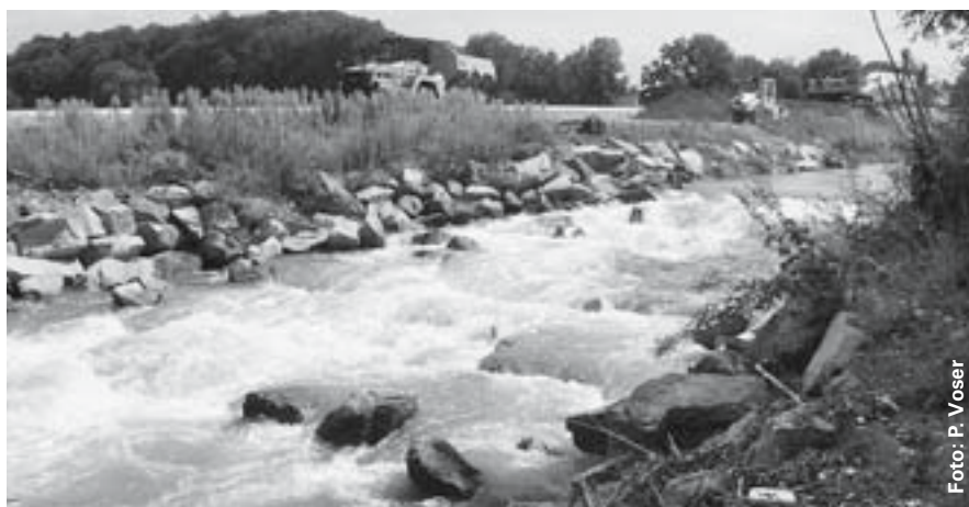
Als Ersatzmassnahme zum Bau des Staffeleggzubringers wurde die unterste Wanderbarriere durch eine Blockrampe ersetzt. Nun können die Fische aus der Aare eine kurze Strecke weiter aufsteigen.
