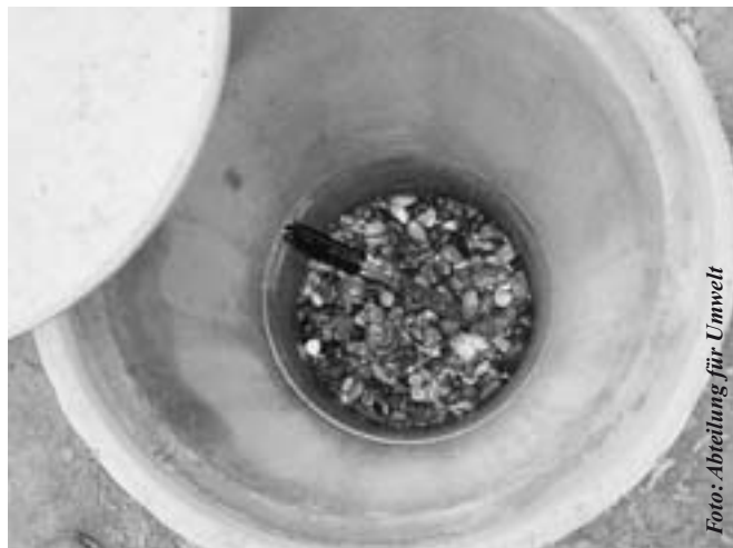
Über einen Schluckbrunnen gelangt das abgekühlte Grundwasser wieder vollständig in den Grundwasserleiter.
