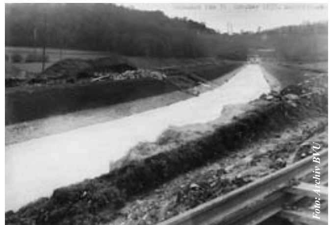
Der neue Bünzkanal nach einem Hochwasser in Othmarsingen 1935 (Blick von der Strassenbrücke Richtung Bahndamm)
