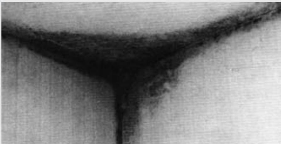
Graue Ecken entstehen bei tiefen Oberflächentemperaturen auf der Innenseite der Aussenwand. Erhöhte Luftfeuchtigkeit verstärkte in diesem Fall die Bildung von grauen Ecken.
