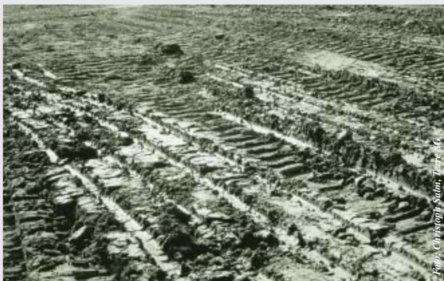
Fahrspuren: In zu feuchtem Zustand ist der Boden besonders verdichtungsanfällig. Er ist plastisch verformbar, wird von den Fahrwerken verschmiert. Schadverdichtungen sind die Folge.
