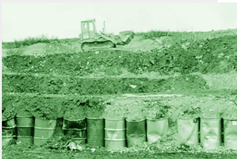
Einbau von Fässern in der Sondermülldeponie Kölliken während der Betriebsphase von 1979 bis 1985
