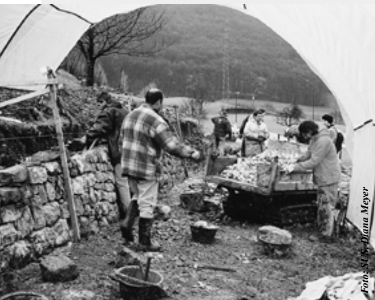
Bau einer Stützmauer in Küttigen
