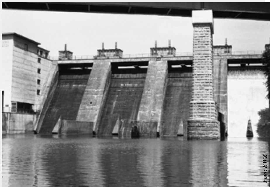
Das Limmatwerk Wettingen gibt beim Wehrfeld 1 600 Liter Restwasser pro Sekunde ab.
