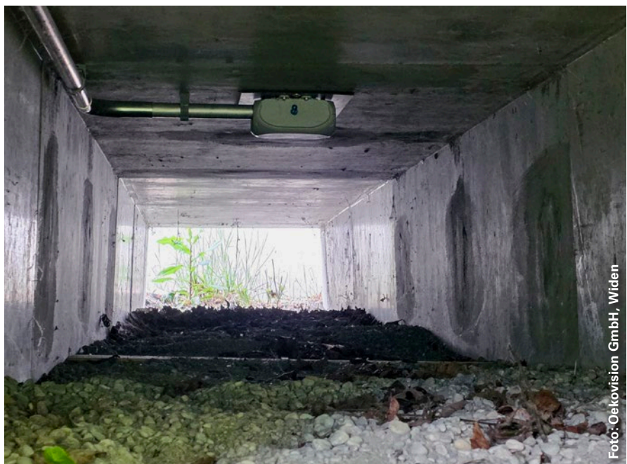
Alle Kleintierdurchlässe in Merenschwand wurden mit Videokameras ausgerüstet und zeichnen jede Bewegung auf.
