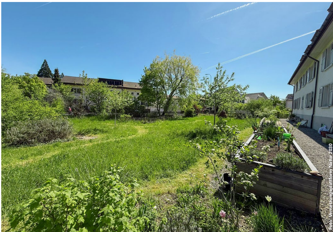
Entwicklung im Bestand als Chance, weitläufige Aussenareale zu erhalten und dennoch mehr Wohnfläche zu gewinnen. Beim Mehrfamilienhaus am Bündtenweg in Aarau ist der Garten zudem neu naturnah gestaltet.
