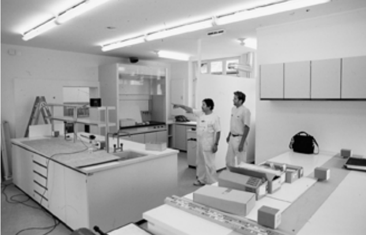
Das neue Labor kurz vor der Fertigstellung
