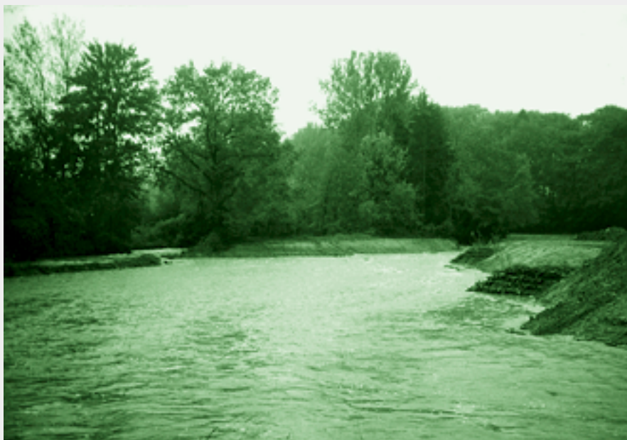
Der Geschiebesammler während des Baus bei einem kleineren Hochwasser.
