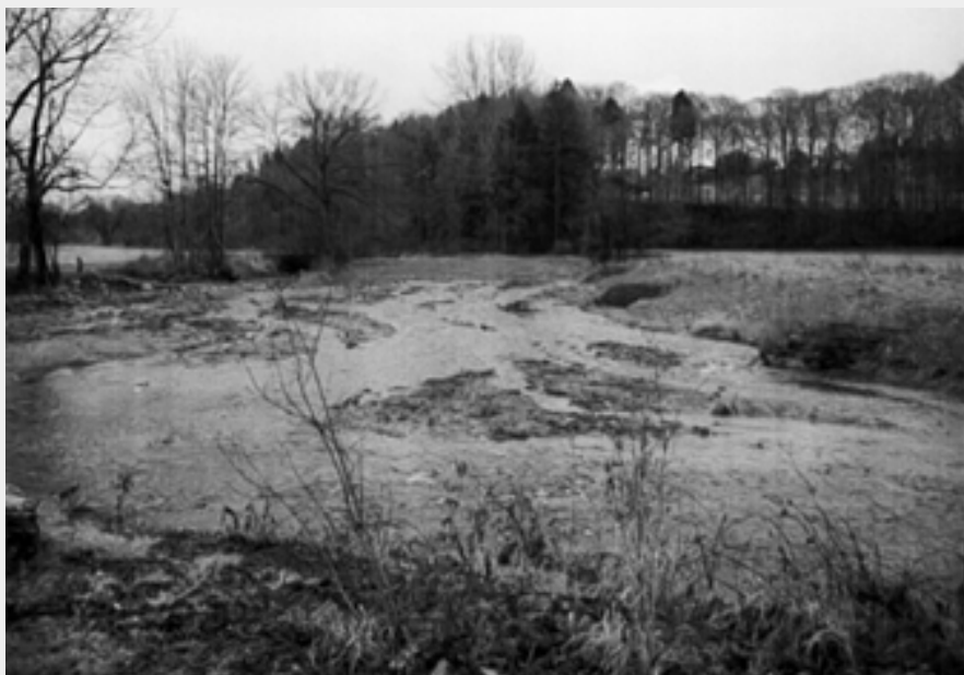
Der Geschiebesammler, wie er sich heute, etwa ein halbes Jahr nach seiner Fertigstellung, präsentiert. Es haben sich bereits verschiedene Wasserläufe und Kiesinseln gebildet.
