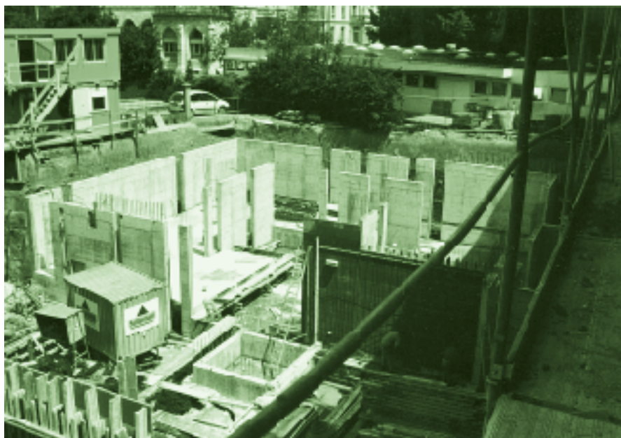
Die Arbeiten beim Neubau schreiten zügig voran.
