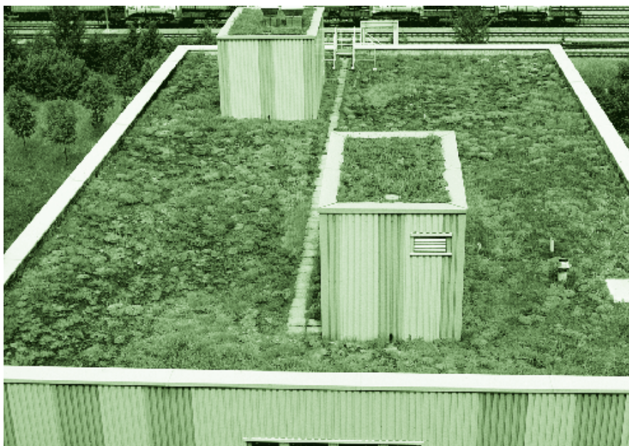
Dachbegrünung bei der Ciba Spezialitätenchemie in Kaisten
