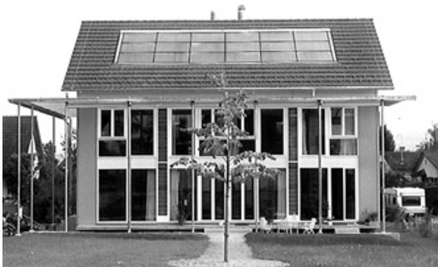
Das Haus der Familie Schimmel in Münchwilen (TG) aus dem Jahr 1994 erfüllt problemlos den MINERGIE-Standard. Der geringe verbleibende Energiebedarf wird vollständig durch erneuerbare Energien abgedeckt.
