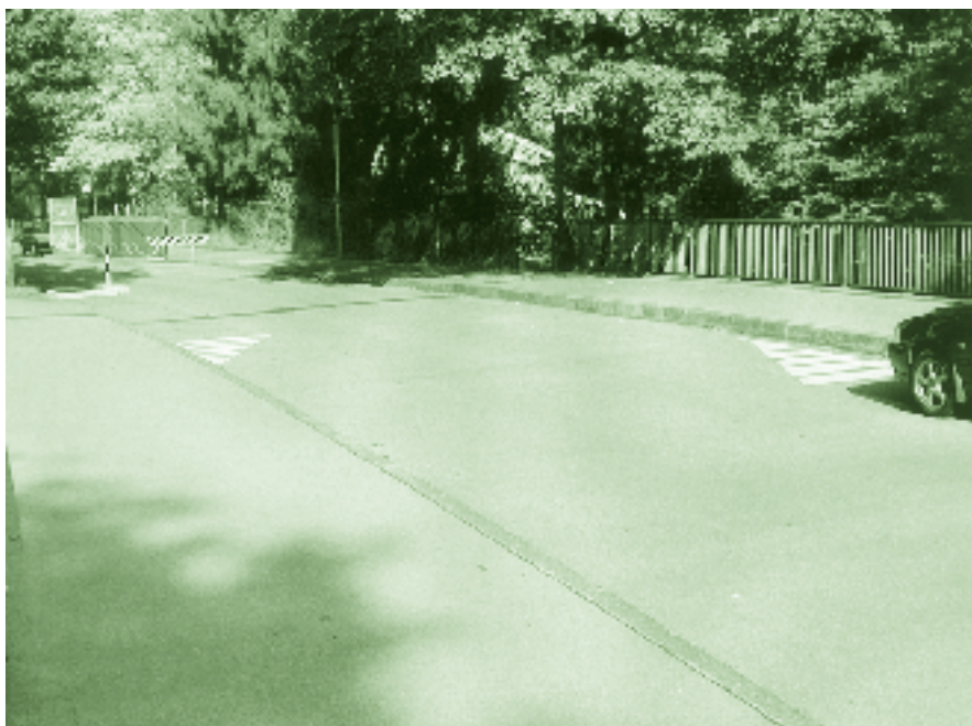
Eine weitere optische Verkehrsberuhigungsmassnahme: Parkfeldabschlüsse.
