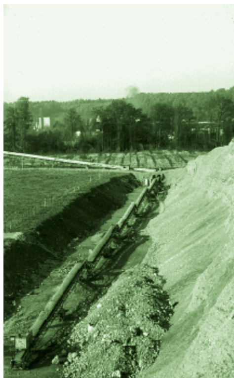
Der Transport zur Aufbereitungsanlage erfolgt mittels Förderband.
