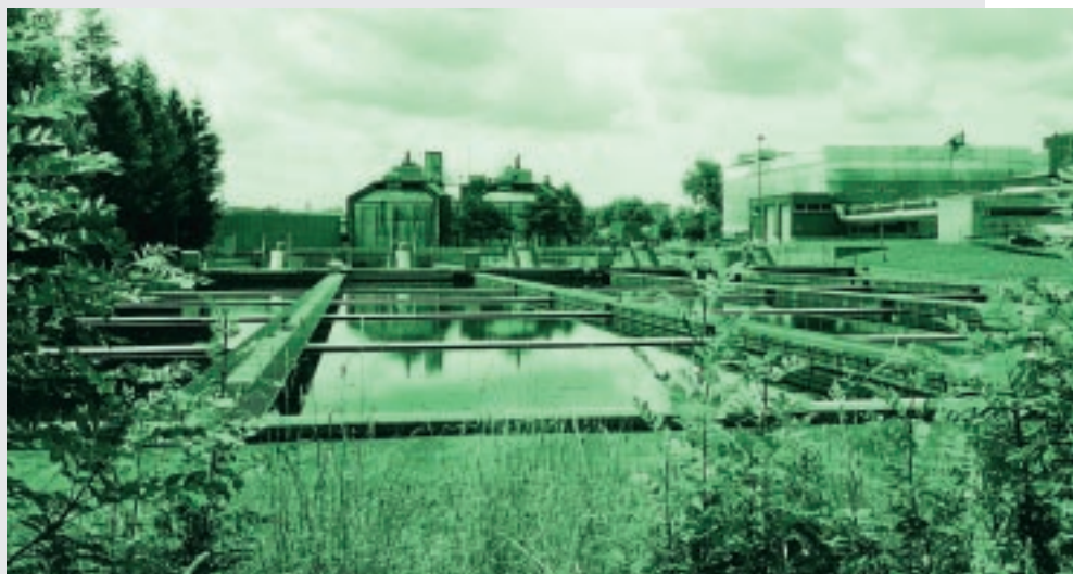
Blick über die Nachklärbecken zu den Schlammfermentern und dem Betriebsgebäude der Abwasserreinigungsanlage Aarau und Umgebung.
