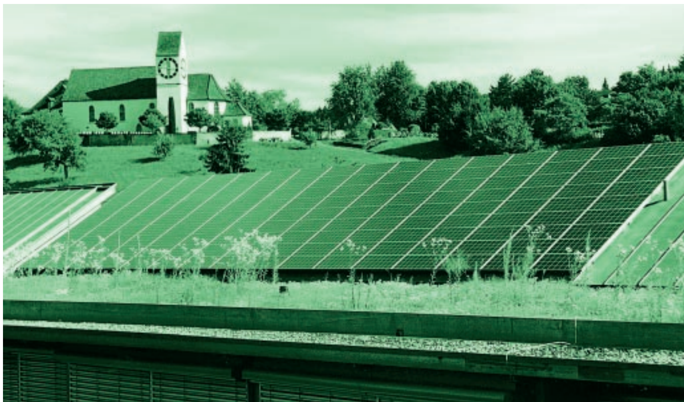
Photovoltaik-Anlage auf dem Dach des Schulhauses in Magden
