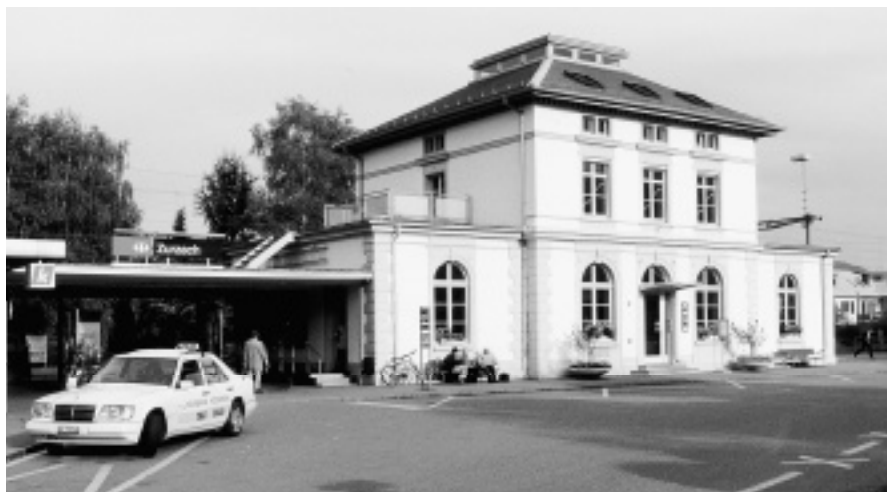
Das Bahnhofgebäude in Zurzach wurde unter Mitwirkung der kantonalen Denkmalpflege renoviert. In den Obergeschossen befinden sich zwei Wohnungen.
