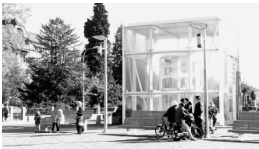
Der Bahnhofplatz Zofingen ist Treffpunkt und Erholungsraum. Im Hintergrund die neue Liftanlage.
