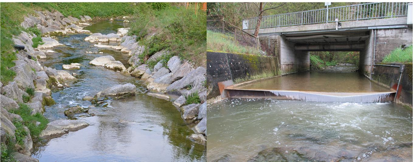
Abb. 1: Erbaute Blockrampe von 2014 (Foto links), welche die Durchgängigkeit für Fische gewährleisten soll. Eingebaute Krebsperre von 2016 (Foto rechts).
