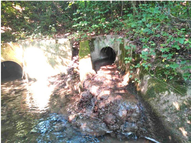
Abb. 6: Einleitung des behandelten Abwassers der Edelkrebs AG in den Schachekanal. Koordinaten: 2672886 / 1228179.
