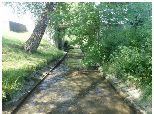
Abb. 18: Stelle E381 unterhalb der Entlastung RU 9f, Kölliken mit Blickrichtung bachaufwärts. Koordinaten: 2643931 / 1241610.
