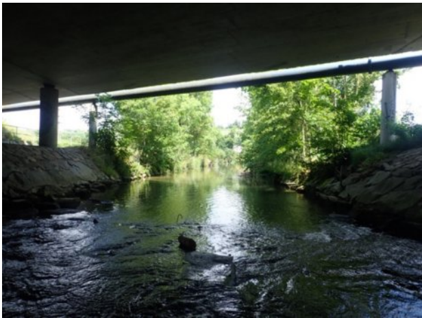
Abb. 8: Stelle E384 oberhalb der Entlastung des Regenbeckens RUB ARA, Frick, mit Blickrichtung bachaufwärts. Koordinaten: 2643690 / 1262708.
