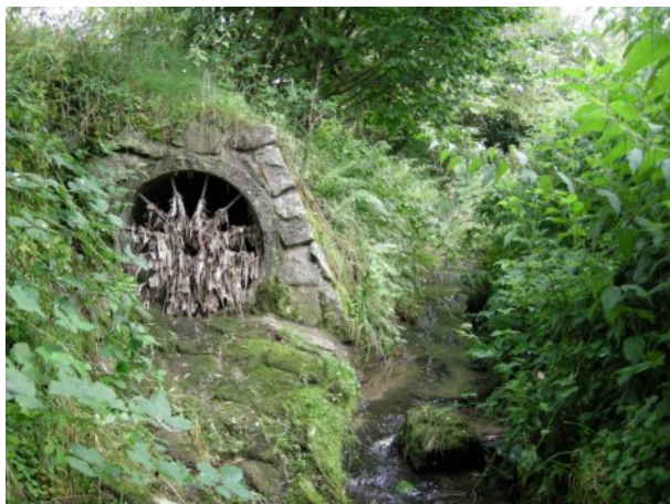
Abb. 62: Einleitung des Fangkanals FK Krebsbach, Ammerswil. Koordinaten: 2658'185 / 1247'093.
