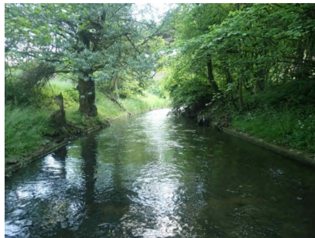
Abb. 99: Stelle E368 unterhalb der Einleitung aus dem Ölabscheider der A1, Othmarsingen. Koordinaten: 2658122 / 125083.
