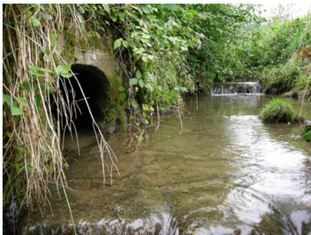
Abb. 67: Ausleitung aus dem RB Regenbecken, Ammerswil. Koordinaten: 2658'766 / 1247'401.
