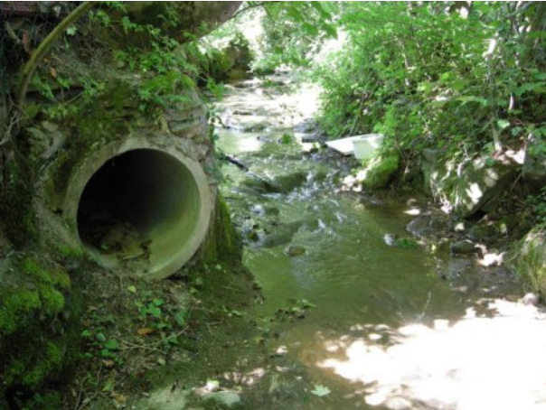
Abb. 41: Ausleitung aus dem Fangkanal Bodenacker, Uezwil. Koordinaten: 2663'161 / 1241'197.
