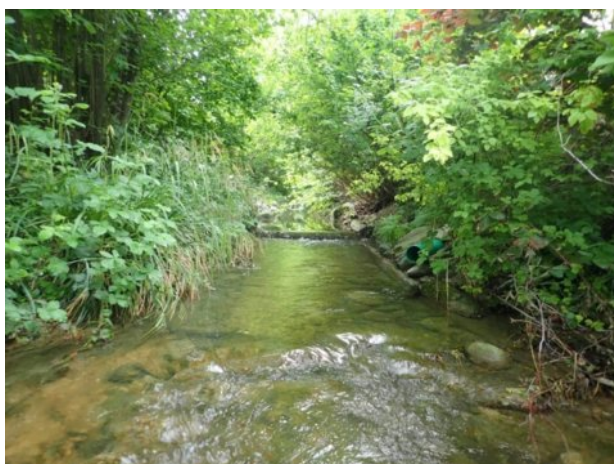
Abb. 88: Stelle E349 am Hinterbach oberhalb des Regenüberlaufes RA 463, Villmergen. Koordinaten: 2661112 / 1244458
