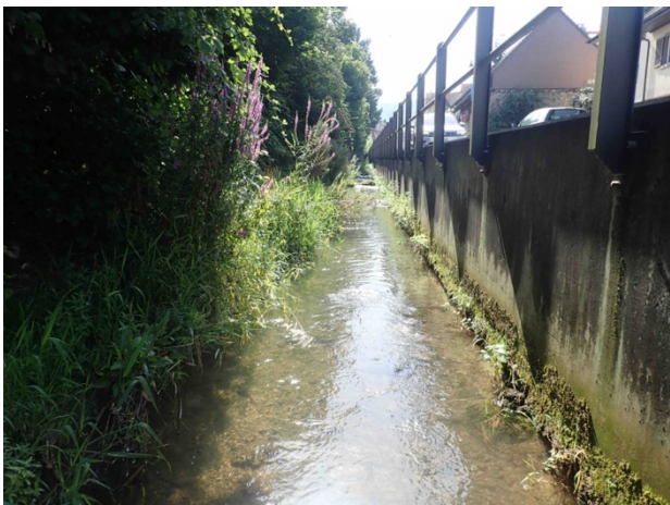
Abb. 15: Stelle E395 am Wintersingerbach unterhalb der Entlastung HWE 4 mit Blickrichtung bachaufwärts. Koordinaten: 2628017 / 1264265.
