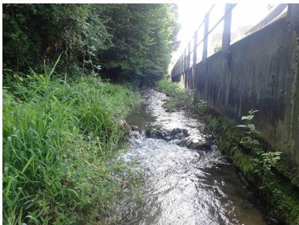
Abb. 14: Stelle E394 am Wintersingerbach oberhalb der Entlastung HWE 4 mit Blickrichtung bachaufwärts. Koordinaten: 2628054 / 1264246.
