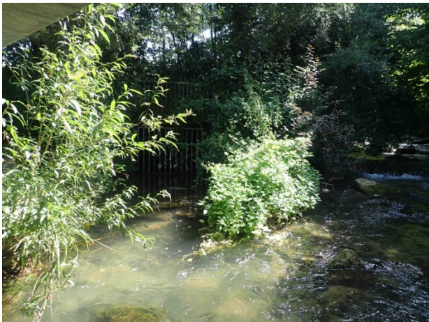
Abb. 6: Einleitung des behandelten Abwassers aus dem Regenbeckens Ziegel matt, Magden in den Magdenerbach. Koordinaten: 2627603 / 1264596.
