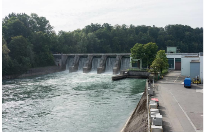
Abbildung 68: Kraftwerk Bremgarten-Zufikon Quelle Foto: © AEW Energie AG, Aarau
