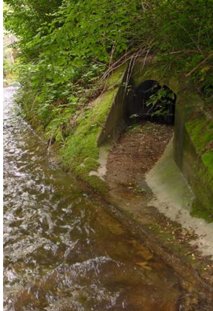
Schlamm durch Rück- stau Bach bei Regen
