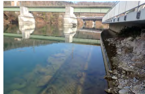
Ufer rechts (Blick abwärts)
