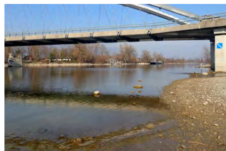
Ufer rechts (Blick abwärts)
