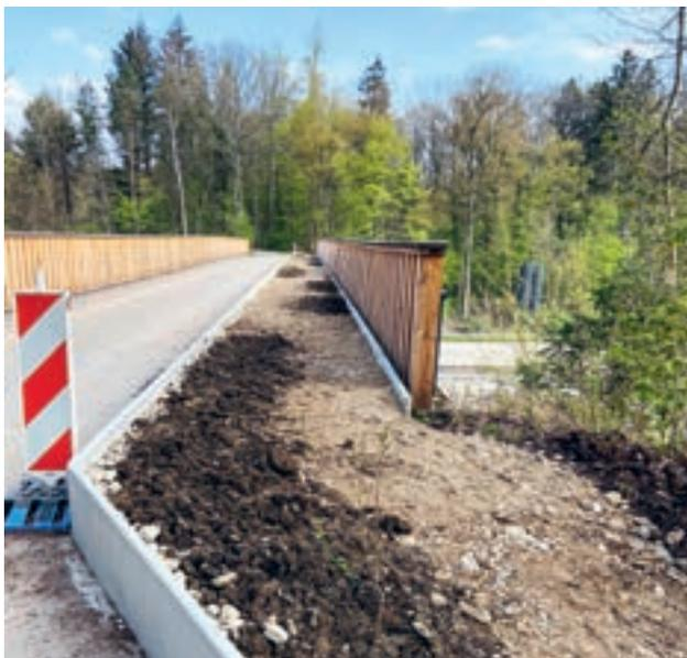
Abb. 11: Diese Überführung über die N03 in Rheinfelden (AG-R01) wurde mit einem Grünstreifen zu einem multifunktionalen Bauwerk umgestaltet (realisiert 2020/2021).
