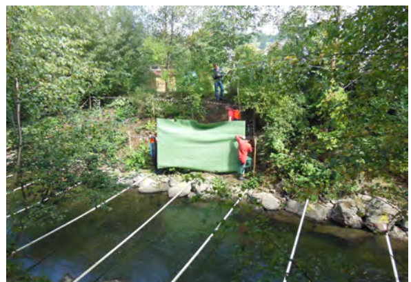
Abb. 5: Verwendung der Schutzwand aus Vlies. Sie wandert mit der applizierenden Person mit (im Bild vom Vlies verdeckt), sodass die Auffangwirkung maximal ist.
