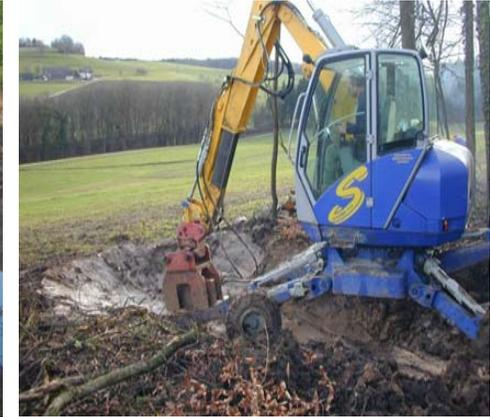
**Gewässererstellung** nach Möglichkeit auf staunass-verdichtbarem Untergrund, wo Mulden in gewünschter Form ausgehoben werden können. Der Aushub kann (je nach Menge) in der Gewässerumgebung zur Terraingestaltung angelegt oder zu einem Unterschlupfwall angelegt werden. Dazu wird der ausgehobene Untergrund teilweise über Asthaufen und Wurzelstockwälle verteilt.
