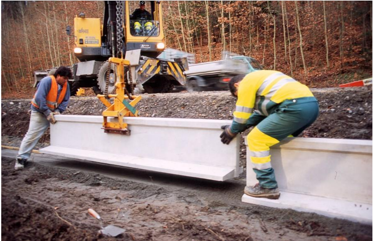
Abbildung 2: Versetzen der vorfabrizierten Amphibien-Leitsteine.
