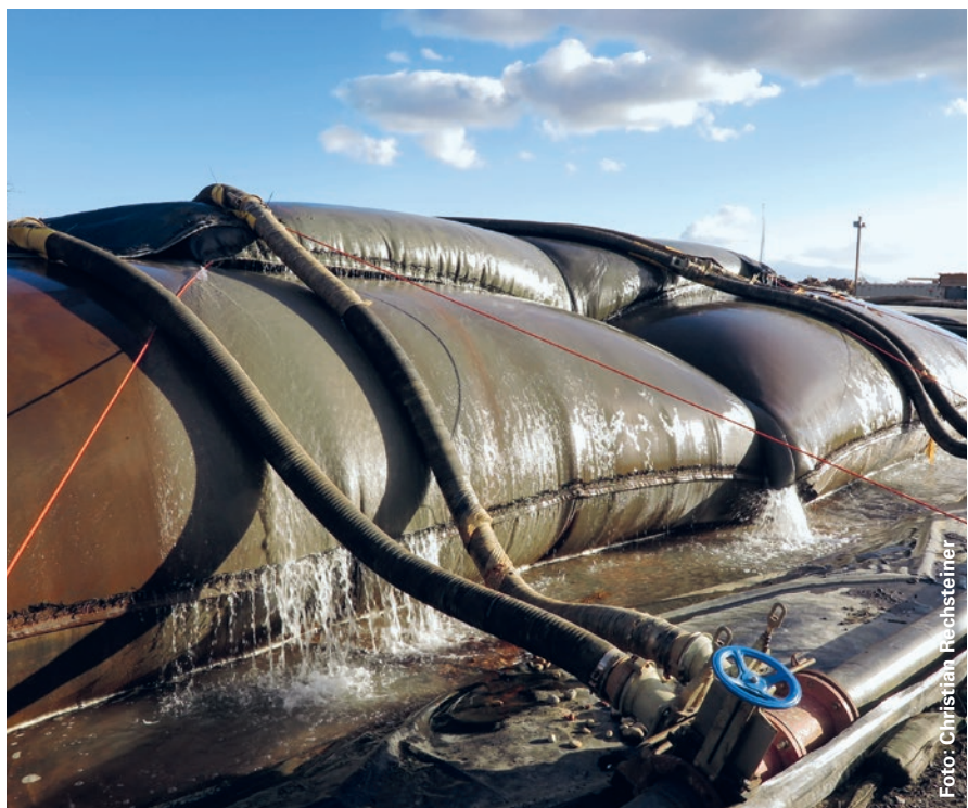
Der abgesaugte Bodenschlamm wurde in den Geotubes entwässert. Das austretende Wasser floss zurück in die Stille Reuss.
