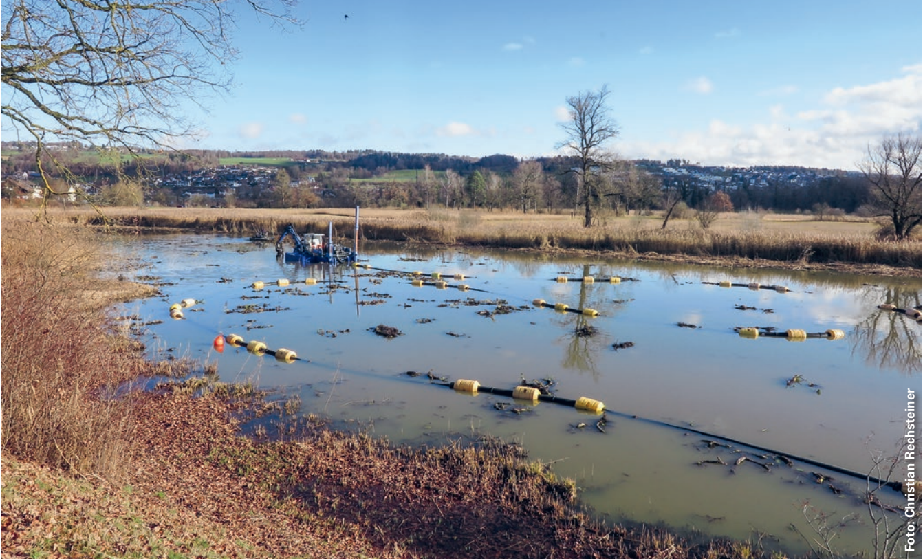
Frühjahr 2022: Mit dem Saugbagger wurde der Bodenschlamm entfernt. Durch die Schläuche wurde er an Land in die Geotubes gepumpt.
