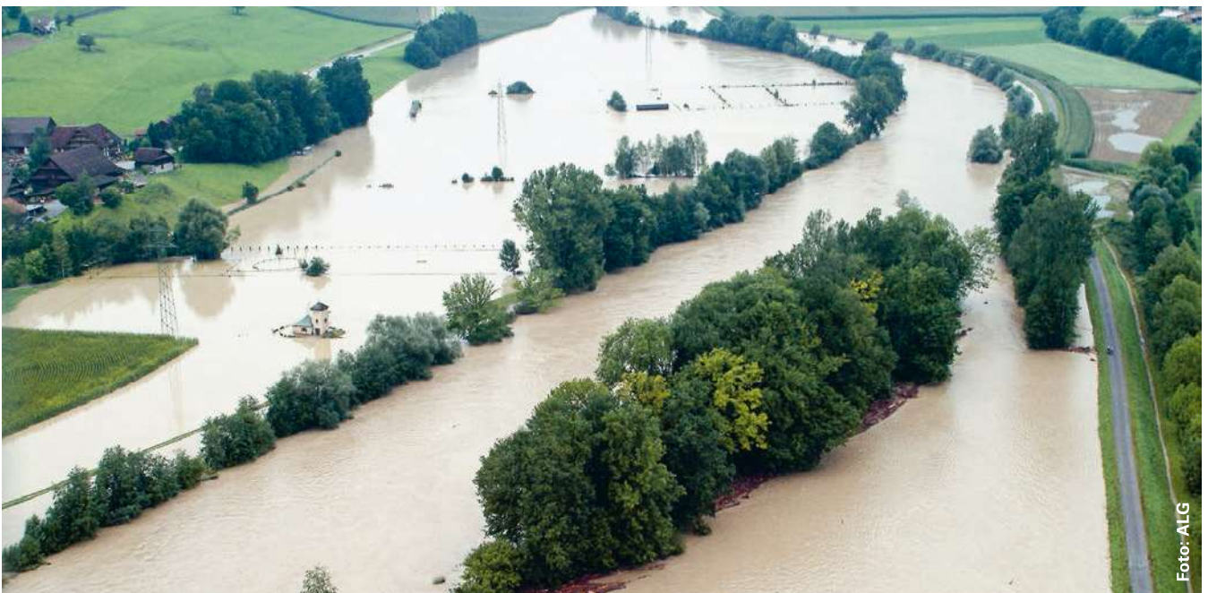
Das Revitalisierungsgebiet Reussegger Schachen in Sins wurde im August 2005 vollständig überflutet. Das Grundwasserpumpwerk ist im Vordergrund in der linken Bildhälfte sichtbar.
