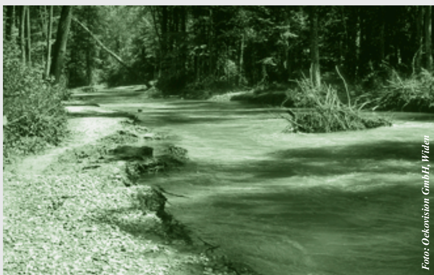
Der neue Seitenarm der Reuss in der Gemeinde Eggenwil hatte nach dem Bau etwas kanalartig gewirkt. Bereits das erste Hochwasser im Juni 2004 nagte an seinen Ufern.
