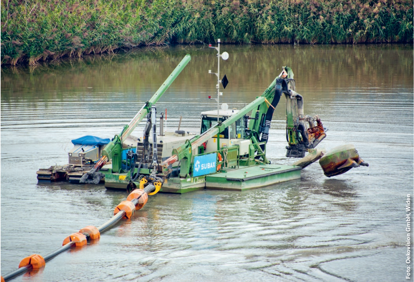
Als Massnahme gegen die Verlandung und Verschilfung werden Feinsedimente im Klingnauer Stausee ausgebaggert.
