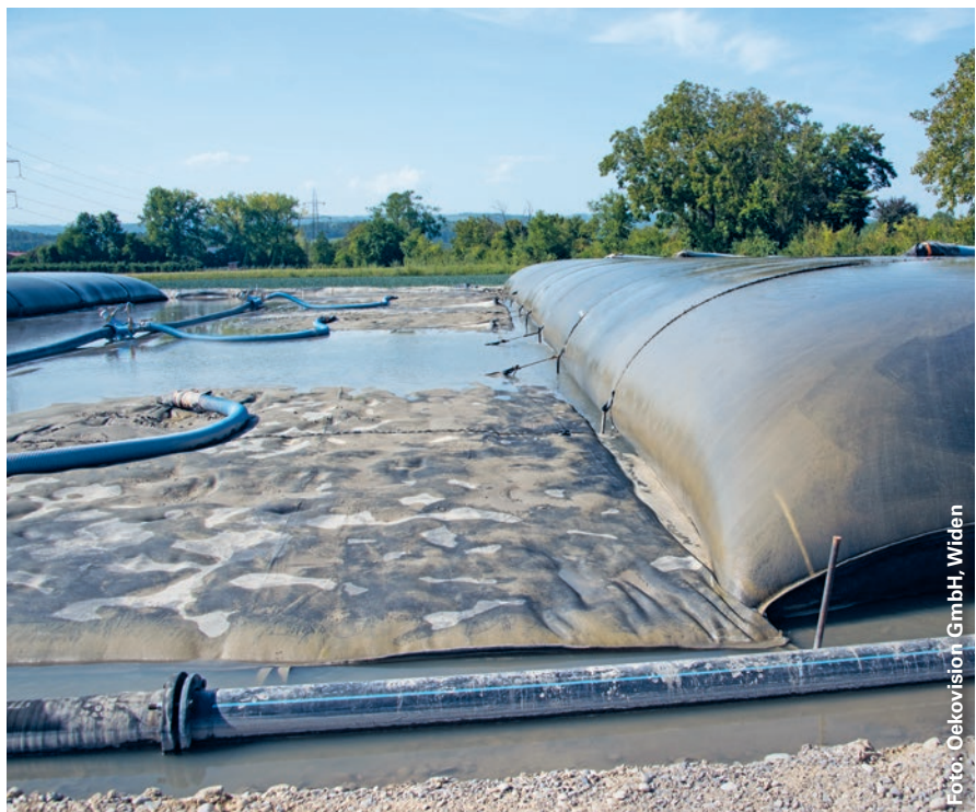
Das mit dem Saugbagger abgesaugte Wasser-Sediment-Gemisch wird in Geotextilsäcke gepumpt und während einigen Monaten getrocknet. Danach kann das Material fachgerecht entsorgt werden.
