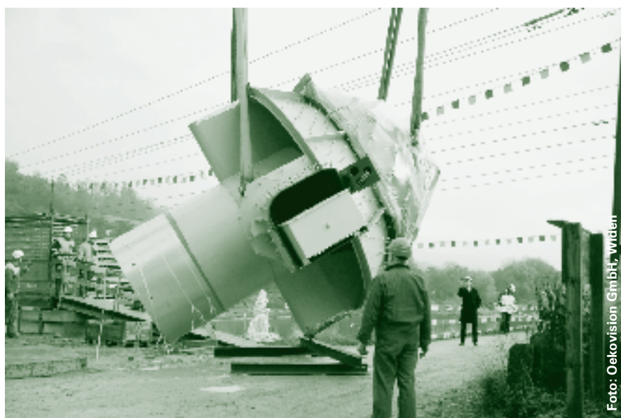
Die neue Dotierturbine für das Kraftwerk Rapperswil-Auenstein wird sorgfältig abgeladen.
