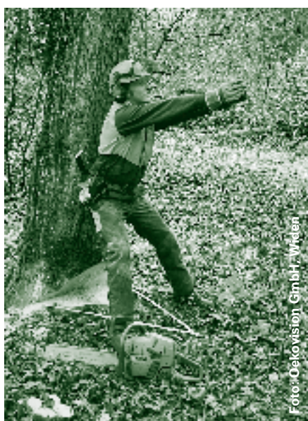
Eine Schneise von knapp fünf Hektaren wird für das neue Seitengewässer durch den Rapperswiler Wald geschlagen.
