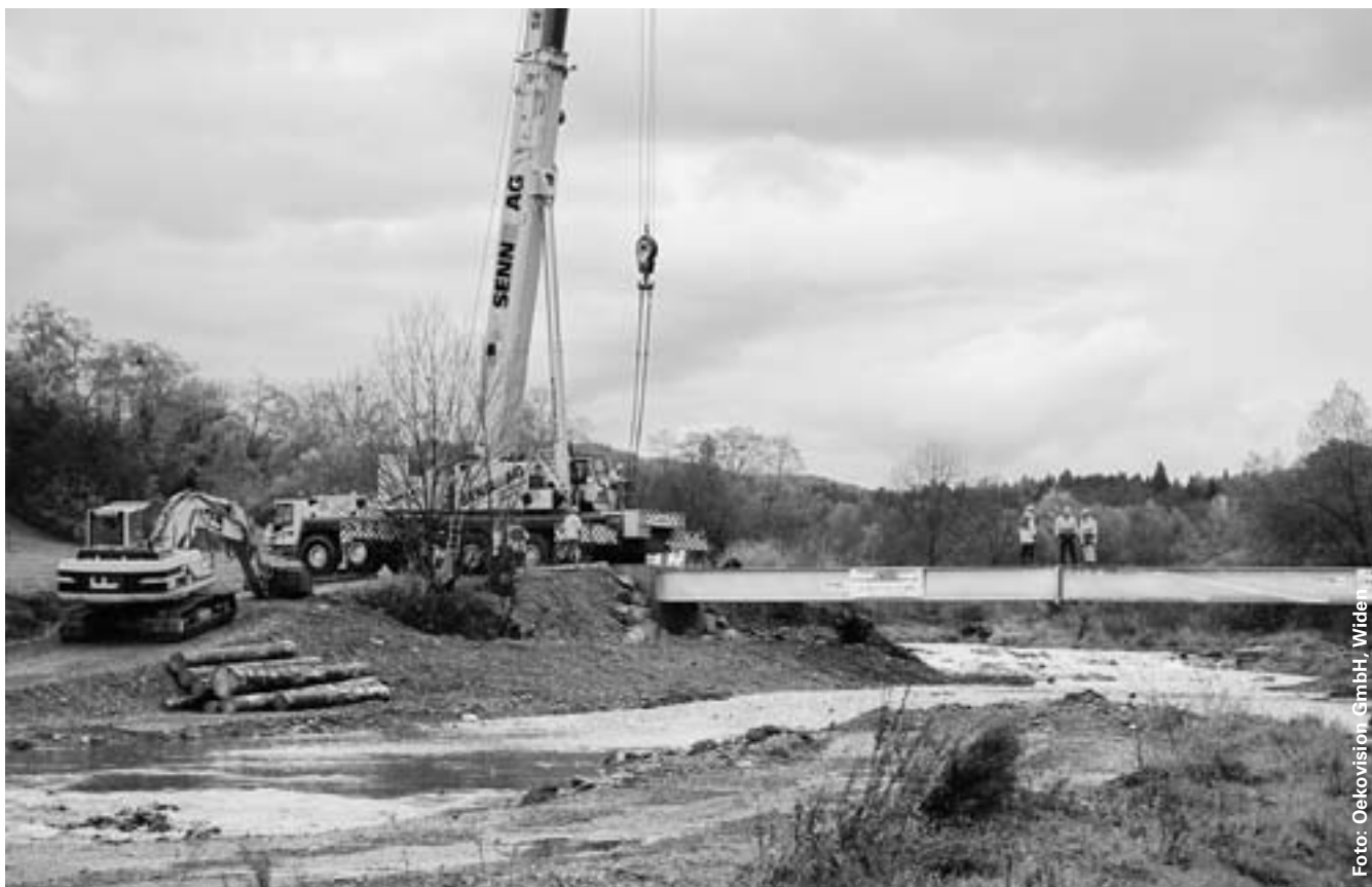
Der Einbau der neuen Roosimatt-Brücke in der Bünzaue Möriken am 4. November 2009.
