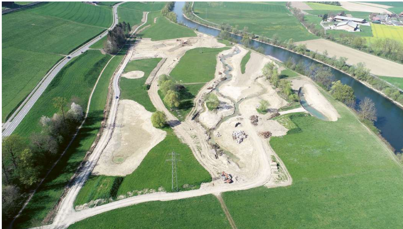
Die Arbeiten der ersten Etappe dauerten von 2019–2020.
