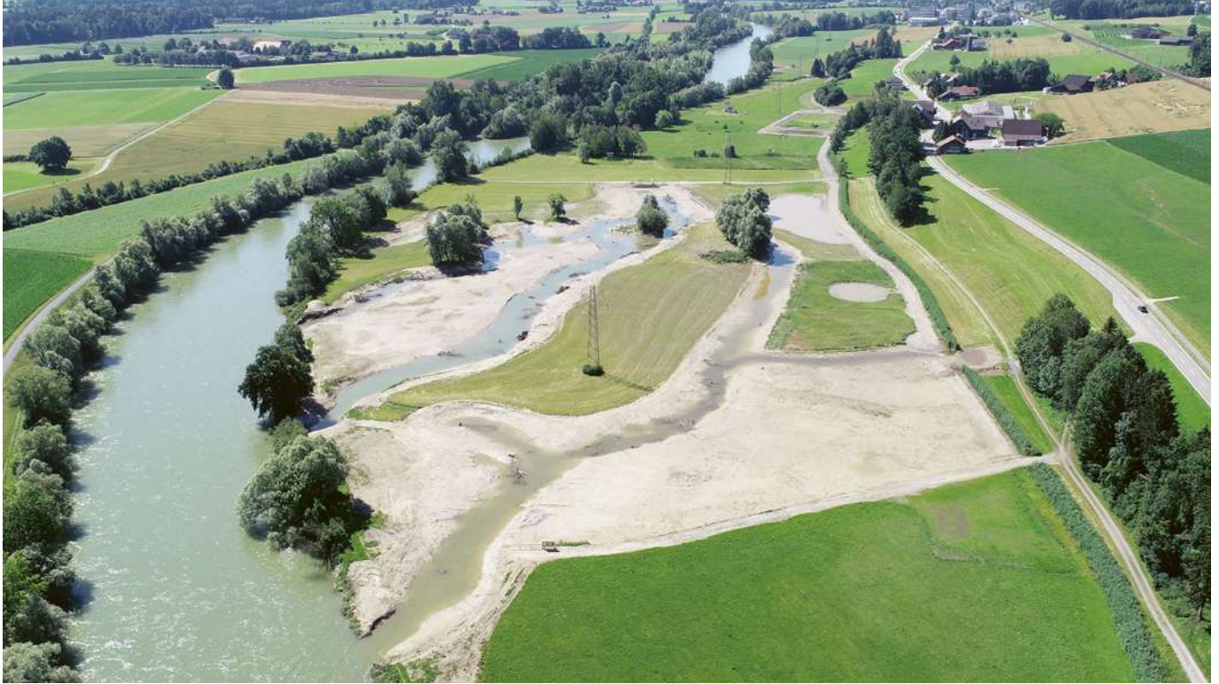
Drohnenaufnahme nach Abschluss der ersten Bauetappe. Die Aufnahme zeigt den aktuellen Zustand der Aue bei Mittelabfluss der Reuss im Jahr 2020. Der Durchstich des Seitenarms wird in der zweiten Bauetappe erstellt.
