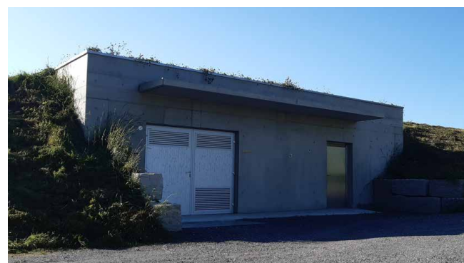
Neu erstellte Grundwasserfassung Reussegg Süd (oben) und dazugehöriges Stufenspumpwerk (unten).
