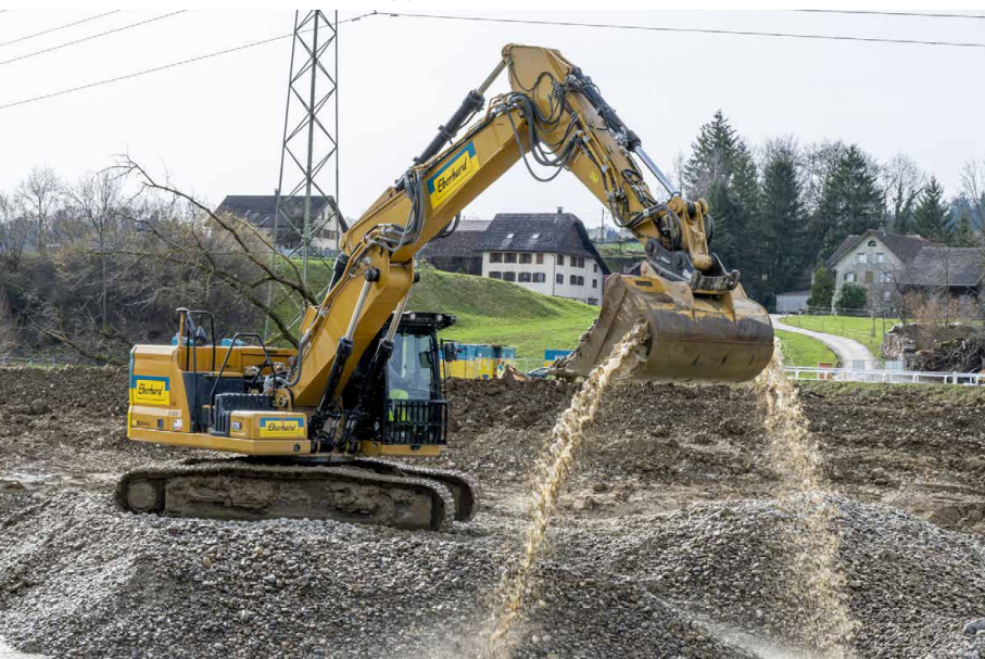
Grabarbeiten mit Bagger im Seitenarm
