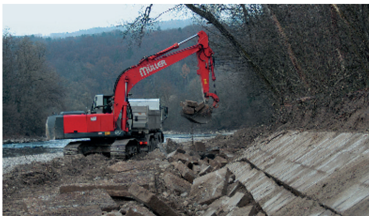
Entfernung der Uferverbauung, die in Reih und Glied gesetzten Betonklötze werden herausgerissen und abtransportiert.
