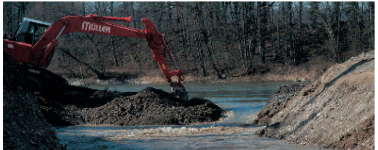
Spektakulärer Durchstich des unteren Seitenarmes.
