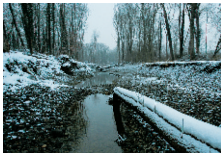
oben: Aushub des Einlaufbereiches des oberen Seitenarmes.
