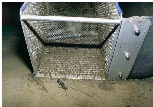
Gute Resultate wurden mit Konstruktionen aus Metall erzielt. Alle beschriebenen Ausstiegseinrichtungen wurden aus rostfreiem Chromnickelstahl 1.4306 erstellt. Es wurde Lochblech mit Bohrung 6 mm, Teilung 9 mm, Materialdicke 2 mm verwendet und der Metallanteil des Lochs beträgt 52%. Dies gewährleistet einerseits eine in sich stabile Konstruktion, andererseits konnte so sichergestellt werden, dass auch kleine Tiere nicht hängen bleiben bzw. sich in den Löchern
