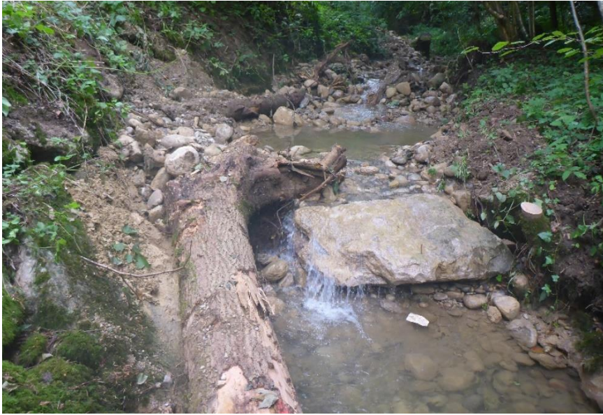
Zwei Schlüsselhölzer in Kombination mit bestehenden Steinen ersetzen zwei hohe kolmatische Steinsohlschwellen/Abstürze (Nr. 36; 02.09.2024). Fliessrichtung:
