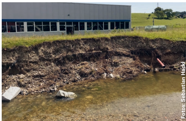
Uferanriss (links) und beschädigter Uferdamm (rechts): Da das Hochwasser nur wenige Monate nach der Fertigstellung des Hochwasserschutzprojektes kam, konnte die Vegetation die Böschungen noch nicht genügend durchwurzeln und stabilisieren.
