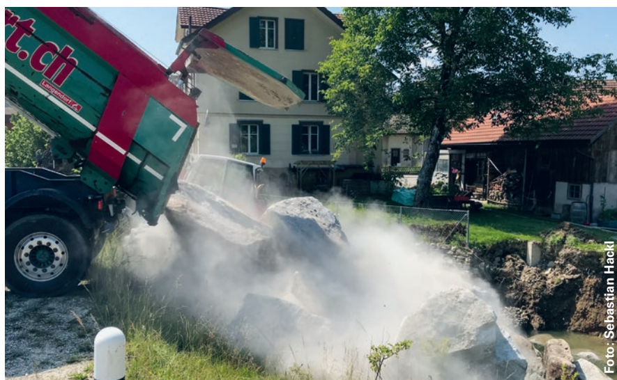
Die beschädigte Ufermauer wird mit neuen Steinen befestigt.
