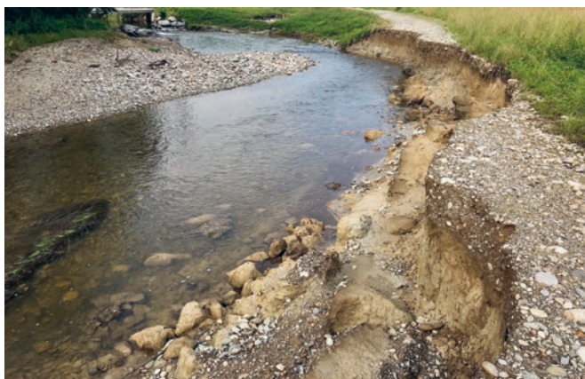
Uferanriss (links) und beschädigter Uferdamm (rechts): Da das Hochwasser nur wenige Monate nach der Fertigstellung des Hochwasserschutzprojektes kam, konnte die Vegetation die Böschungen noch nicht genügend durchwurzeln und stabilisieren.
