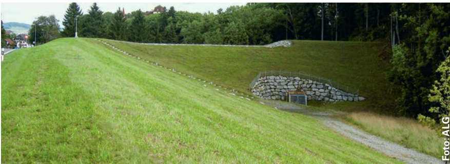
Vor der Realisierung des HRB Schloss musste im Siedlungsgebiet von Villmergen und Hilfikon schon bei einem 5- bis 10-jährlichen Hochwasser mit Schäden gerechnet werden. Seit dem Bau des HRB ist ein Schutz bis zu einem 100-jährlichen Ereignis gewährleistet.
