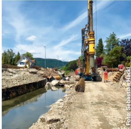
*Erstellung der Bohrpfähle für die neue Brücke und die neue Ufermauer im Weiler Gländ.*
