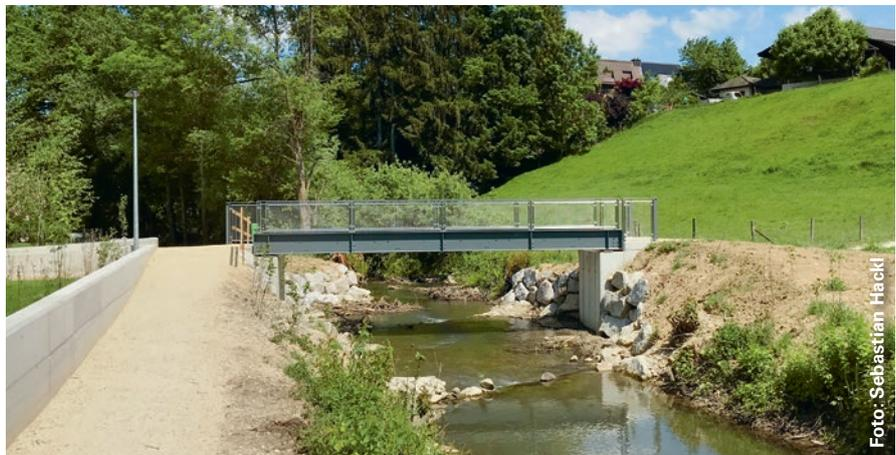
*So wird das Hochwasserschutzdefizit in Vordemwald behoben: Schutz des Siedlungsgebiets (Betonmauer), Verbesserung der Abflusskapazität (neue, erhöhte Brücke) und Strukturierungsmassnahmen im Gewässer (Holzelemente).*
