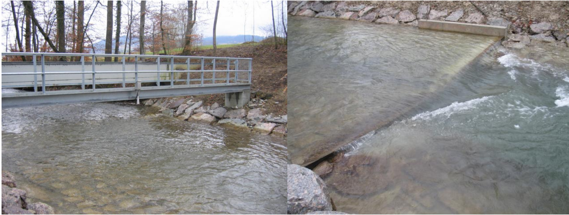
Aabach-Seengen: neue Messstation ca. 100 m oberhalb der alten mit neuem Messsteg für Eichungen (links) und neuer, speziell fischgängiger Messschwelle (rechts).
