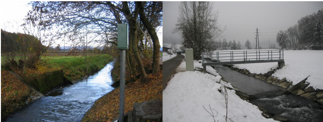
Uerke-Holziken vor Umbau: Fischbecken, keine Vernetzung,
