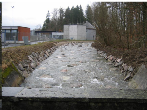
Aabach-Seengen nach Umbau: Überwindung alter Messüberfall mit aufgelöster Blockrampe
