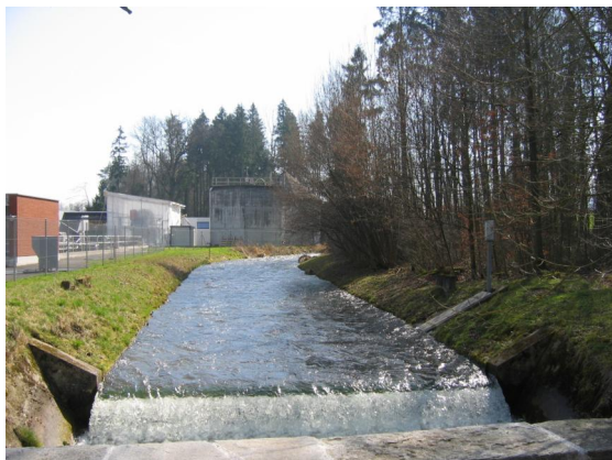
Aabach-Seengen vor Umbau: 1 m Schwelle, keine Vernetzung, kein Messsteg für Eichung
