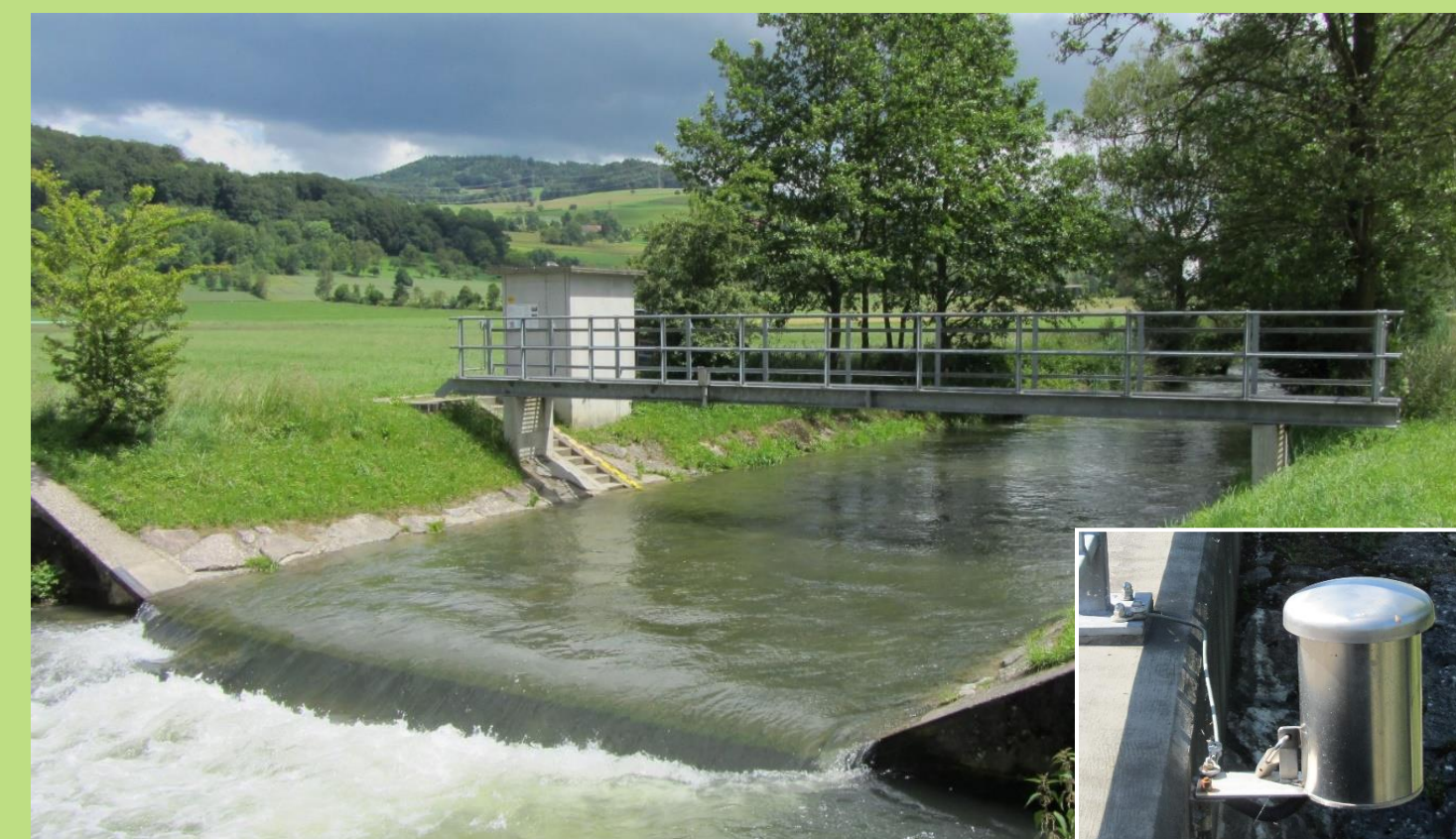
Messstation Suhre in Reitnau mit Radar für die Pegelmessung
