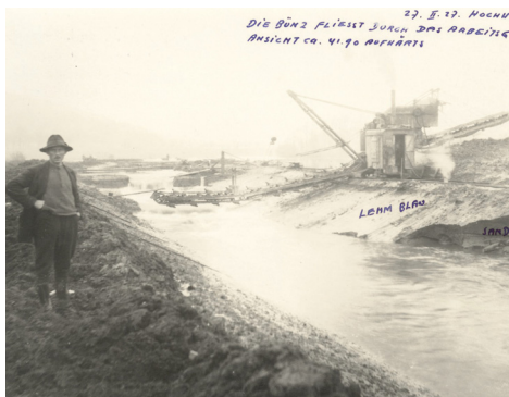
Baustelle während der Bünzkorrektion 1927
