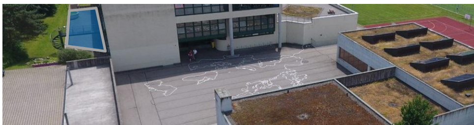
Abbildung 8: Schulhausplatz (Ansicht Nordwestfassade Schulhausgebäude) mit markiertem Bereich, welcher einstaut
