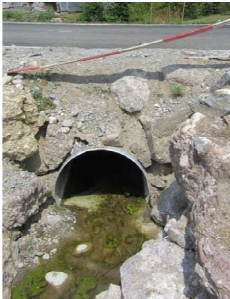
Abbildung 5 Durchlass Schönismattbach in Fließrichtung
