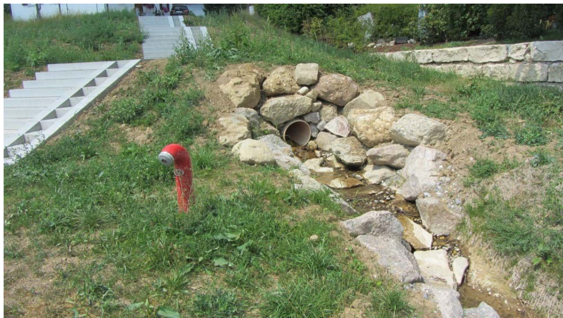
Abbildung 4 Neuer Durchlass des Dorfbachs Nesselbach
