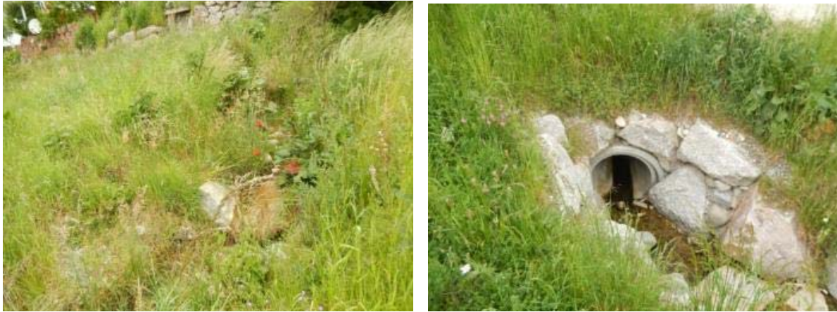
Abbildung 4: Offene Bachführung zwischen der Breit- und der Kesselackerstrasse (links) und Eindolung an der Breitstrasse (rechts).
