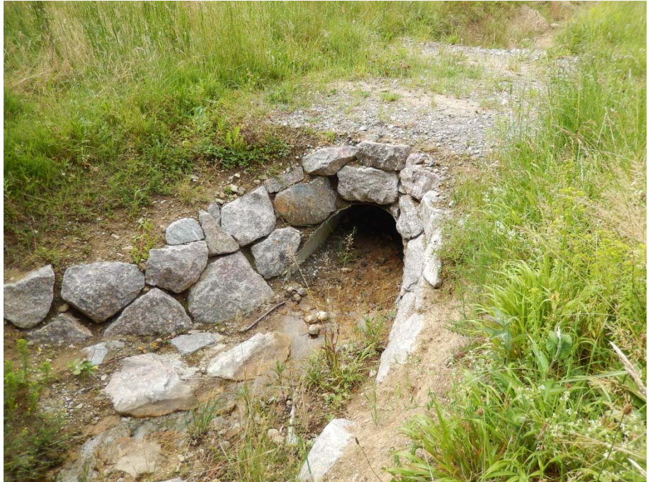
Abbildung 6: Überfahrt über den eingedolten Bachverlauf.
