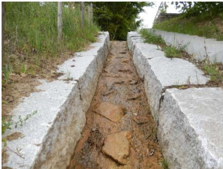
Abbildung 7: Schussrinne (links) und Einlauf mit Rechen (rechts) an der Eindolung Knobelstrasse (Zustand 2015).
