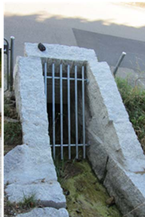
Abbildung 7: Schussrinne (links) und Einlauf mit Rechen (rechts) an der Eindolung Knobelstrasse (Zustand 2015).
