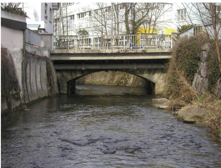
Bünz Wohlen Zentralstrasse Km 13.061 Austrittsstelle W- Bü 10
