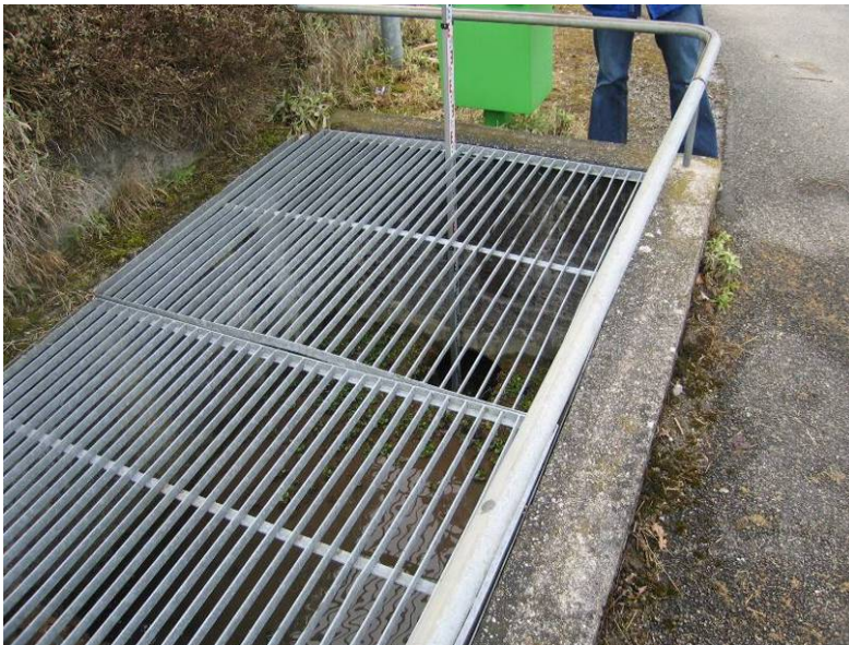
Tobelbach Waltenschwil Sonne Austrittsstelle Wa-To 1
