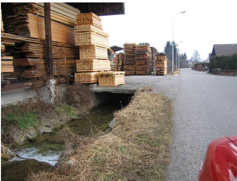
Erusbach Villmergen Bachstrasse Km 0.425 Austrittsstelle V-Er 8
