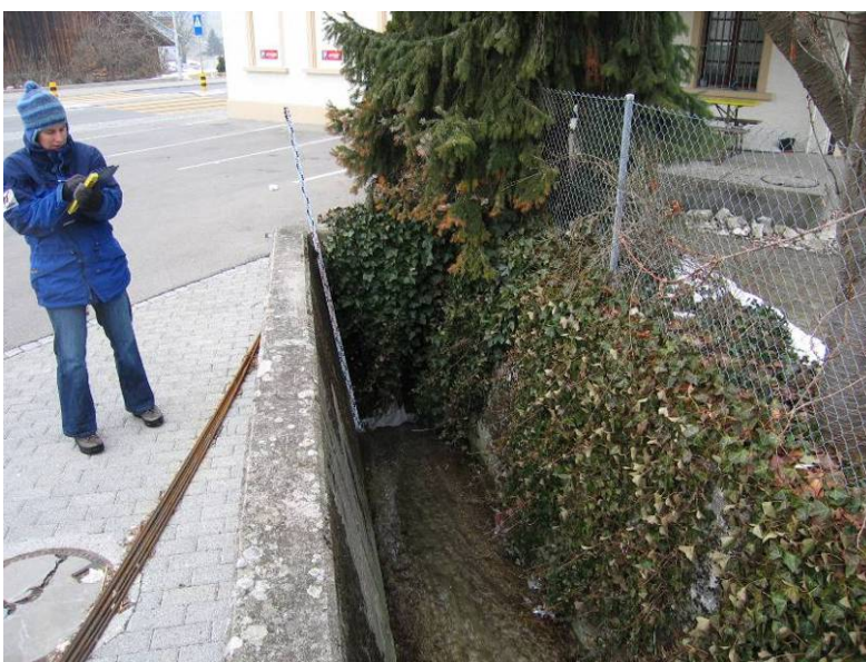
Erusbach Sarmenstorf Sarmenstorferstrasse Austrittsstelle S-Er 2
