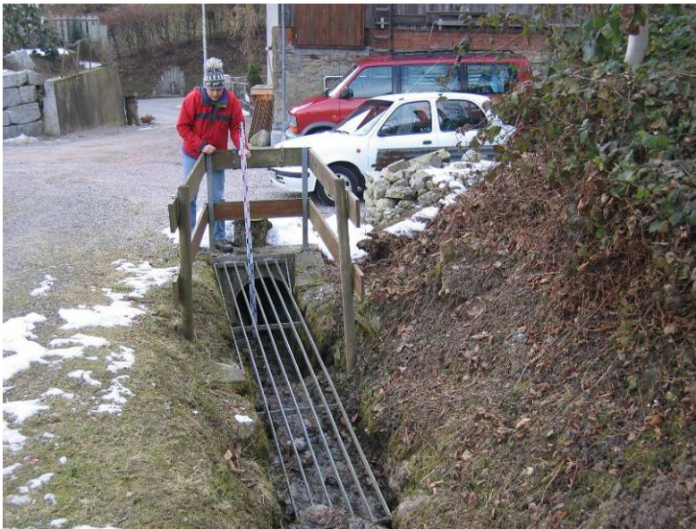
Chriesilochbach Villmergen Chaibengasse Austrittsstelle V-Ch 2
