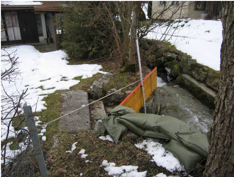
Erusbach Hilfikon Schulhaus Austrittsstelle H-Er 4
