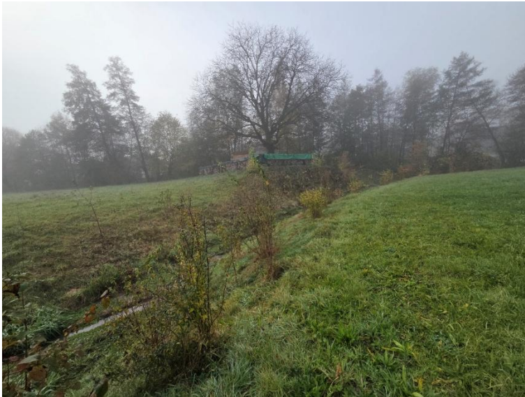
Abbildung 6: Bachoffenlegung im Mündungsbereich der Surb
