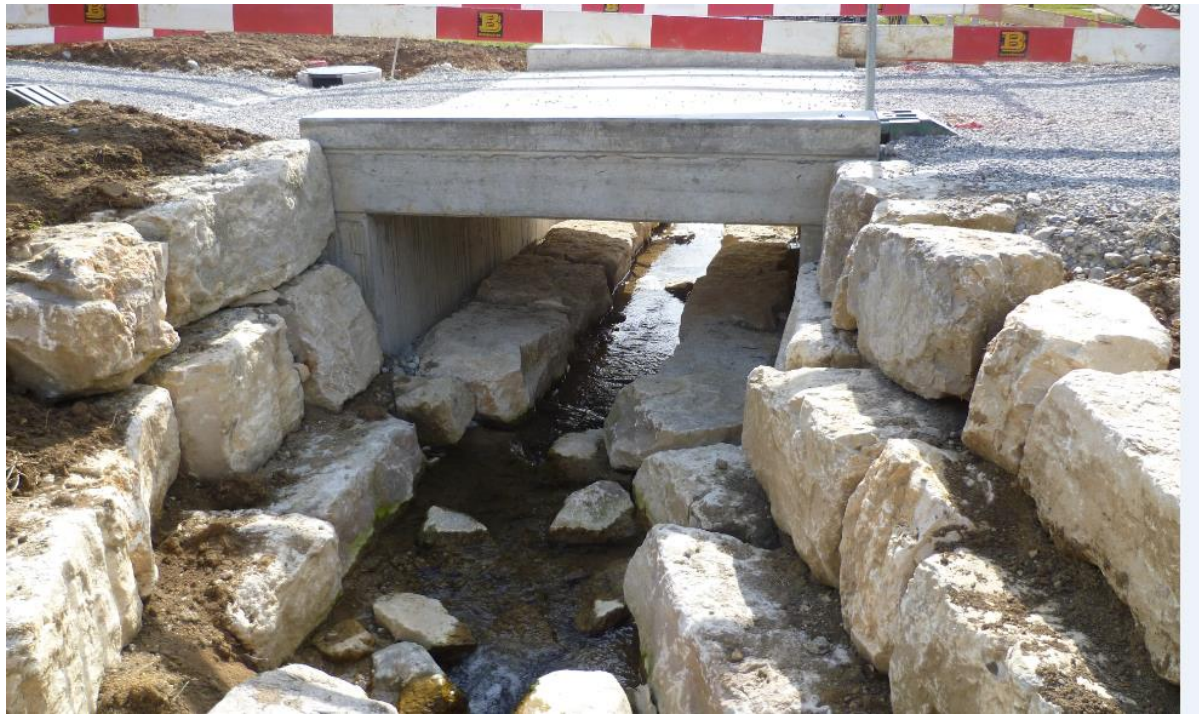
Abbildung 4: Foto ausgeführtes Bauwerk (Begehung 17.03.2015)
