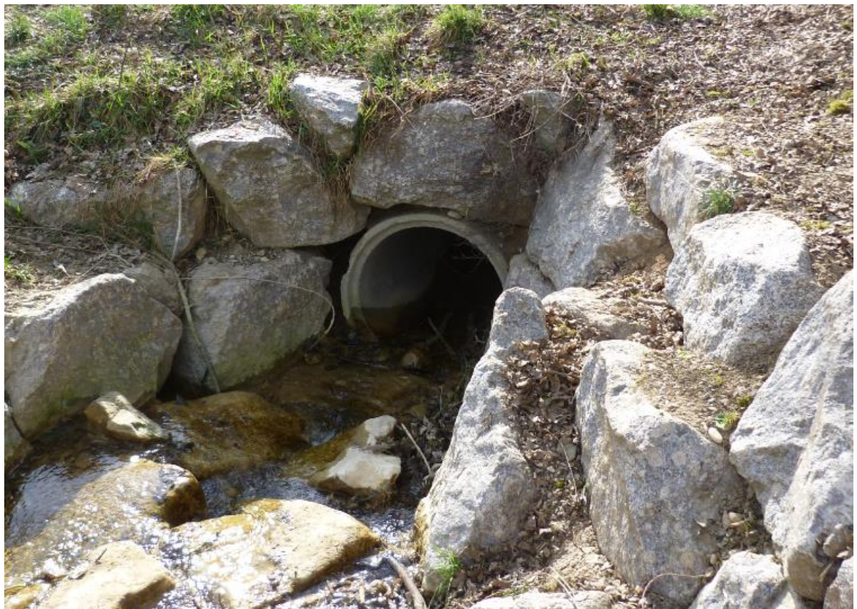
Abbildung 6: Foto des ausgeführten Bauwerks Durchlass 208 (Begehung 17.03.2015)
