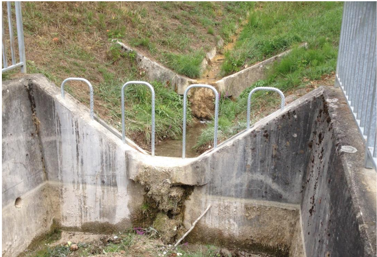
Abbildung 7: Foto der neuen Rechenstäbe oberhalb des Einlaufs Schiltihaldenbach
