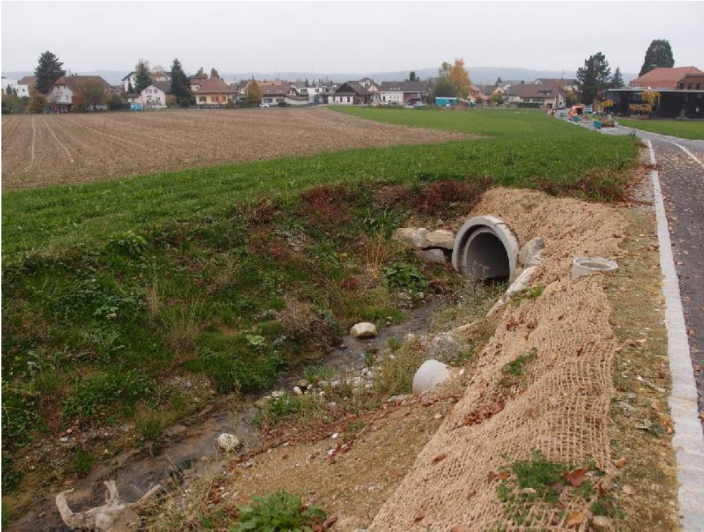
Foto 3 Neubau Durchlass D3 unterhalb Erschliessungsstrasse Hirziweg-West, Rohrdurchmesser: 1200 mm (Schwachstelle MUH042, Ansicht Fliessrichtung)
