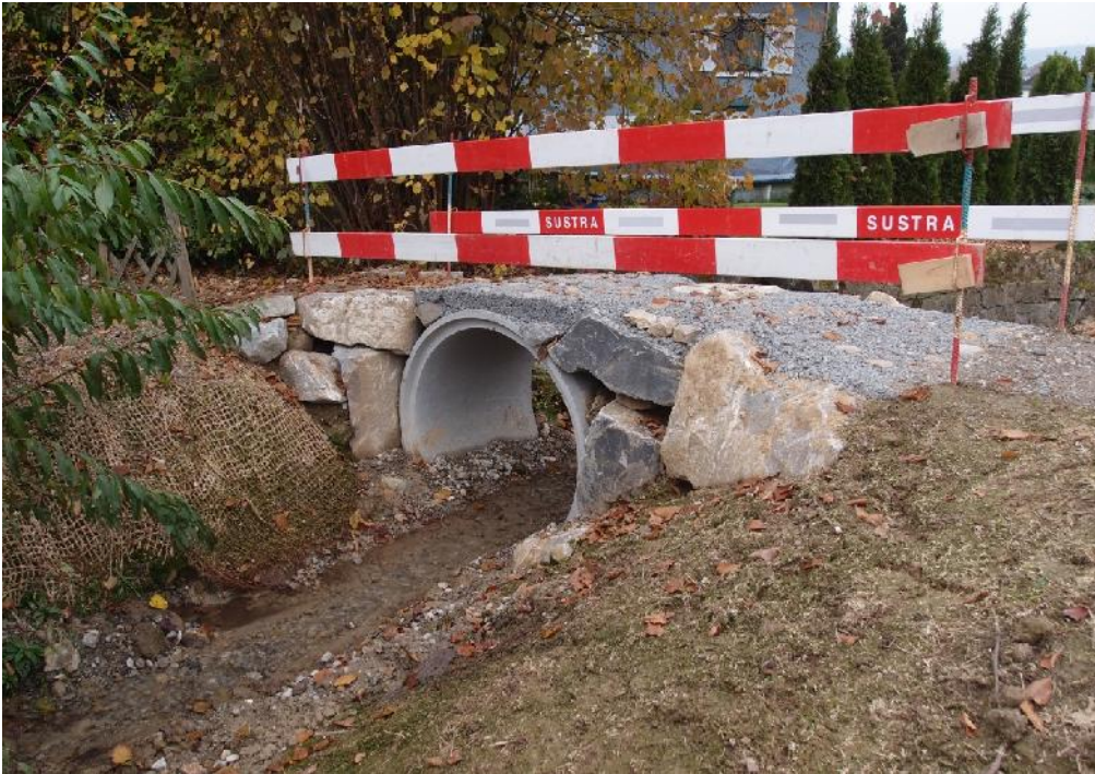
Foto 1 Ersatz Durchlass D1, neuer Rohrdurchmesser: 1250 mm (Schwachstelle MUH040, Ansicht Fliessrichtung)
