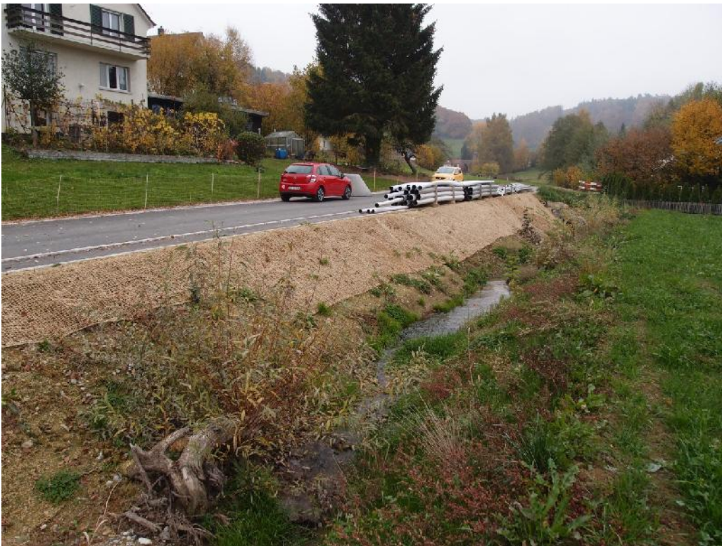
Foto 4 Verlegte und verbreiterte Gerinne auf einer Länge von 60 m (der Busch im Gerinne wurde entfernt, Ansicht flussaufwärts)
