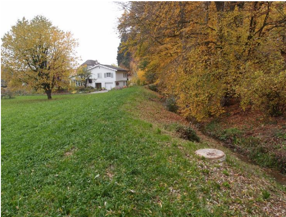
Foto 5 Dammerhöhung und Aufweitung des Schwobistelbächlein nach Durchlass D3 auf einer Länge von 100°m (Ansicht Fliessrichtung)
