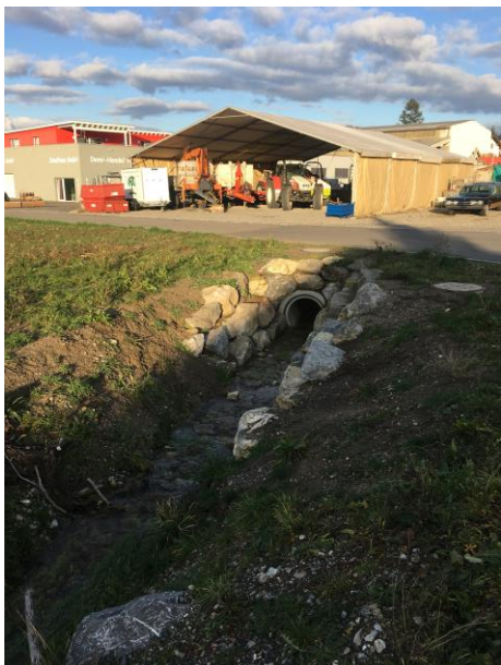
Abbildung 3 Ende Bachverlegung: Einlaufbauwerk Grenzbach / angrenzendes Feld
