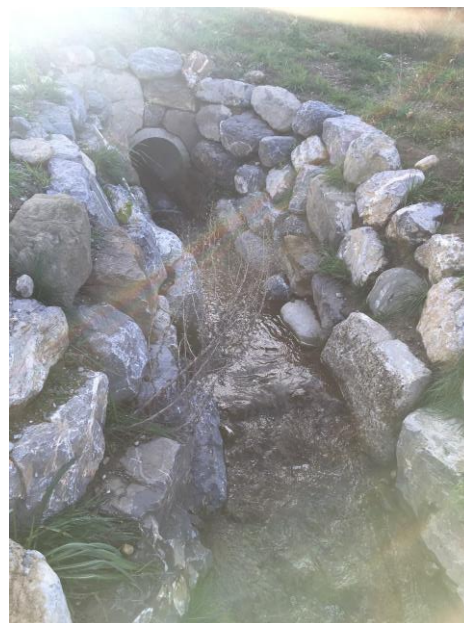
Abbildung 4 Einlauf und Auslauf der neuen Eindolung (DN700) zur Querung der Bahnlinie
