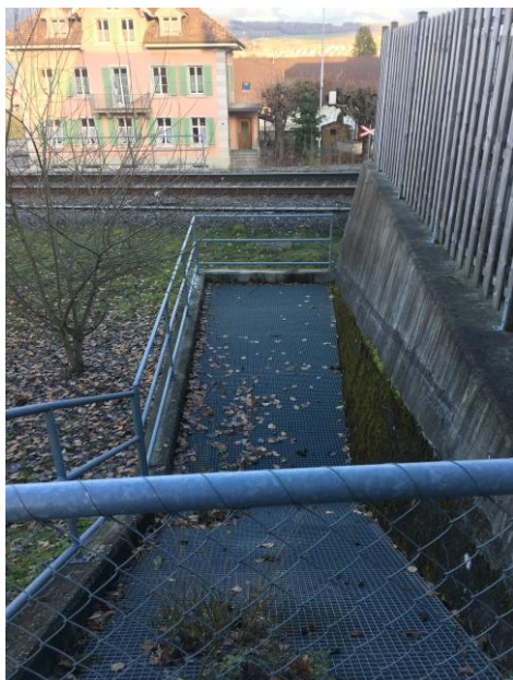
Abbildung 4 Einlauf und Auslauf der neuen Eindolung (DN700) zur Querung der Bahnlinie
